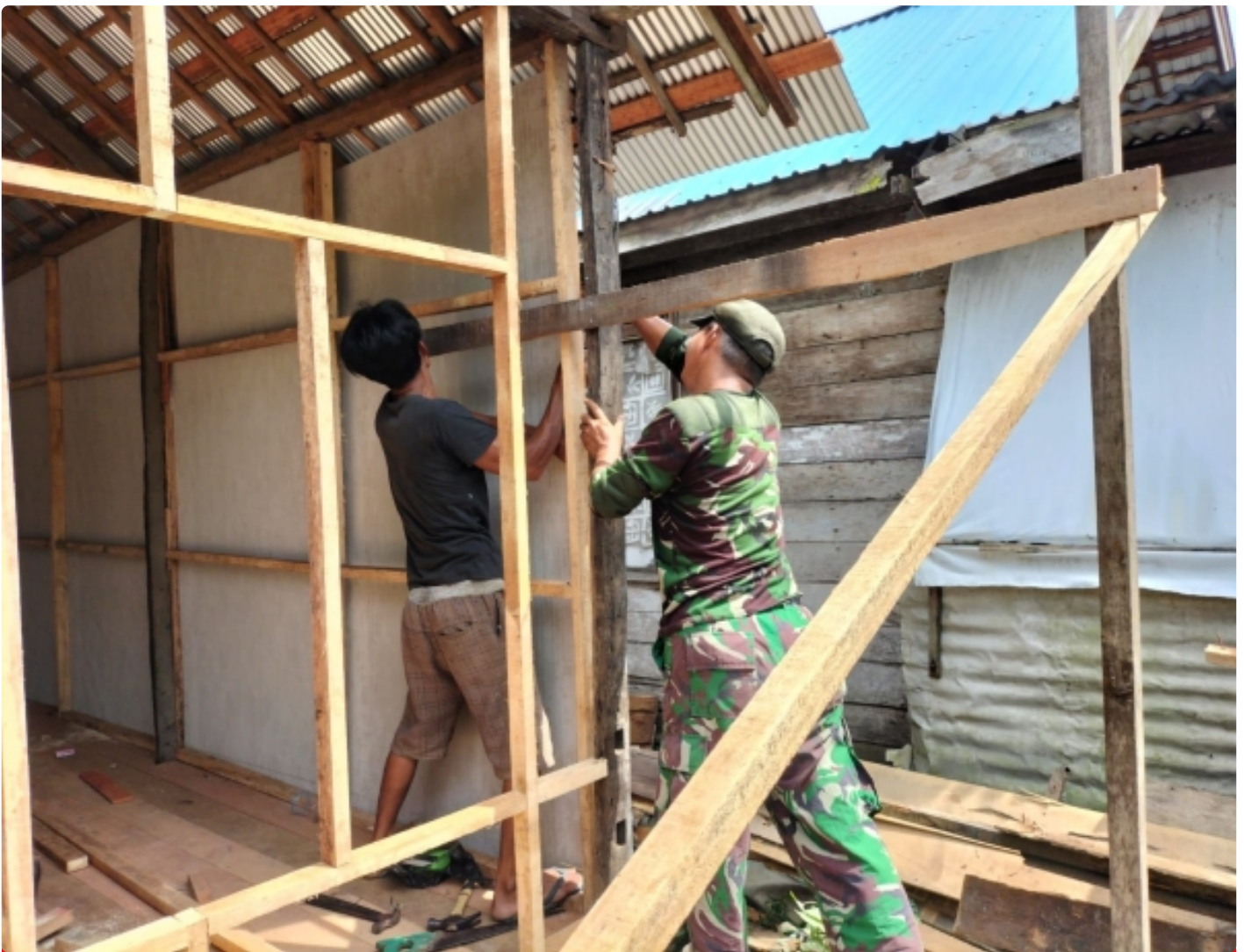
Pemasangan Dinding Rehab RTLH, Kodim 1002/HST
