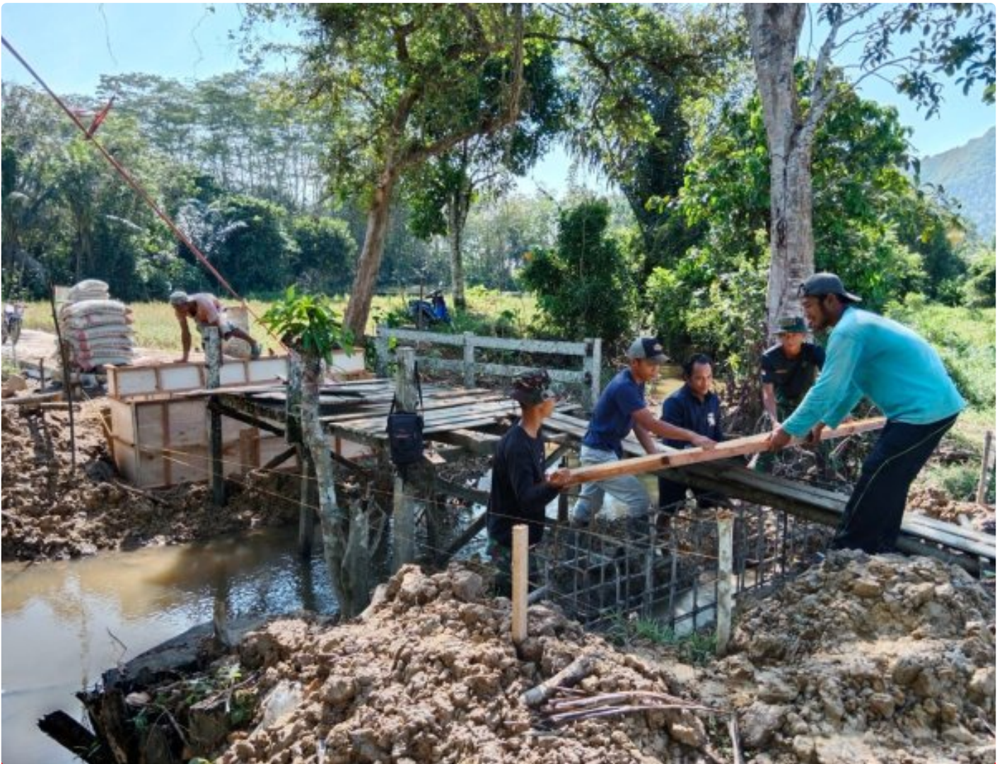
Progres Pengerjaan Jembatan, Satgas TMMD Cor Abutment
